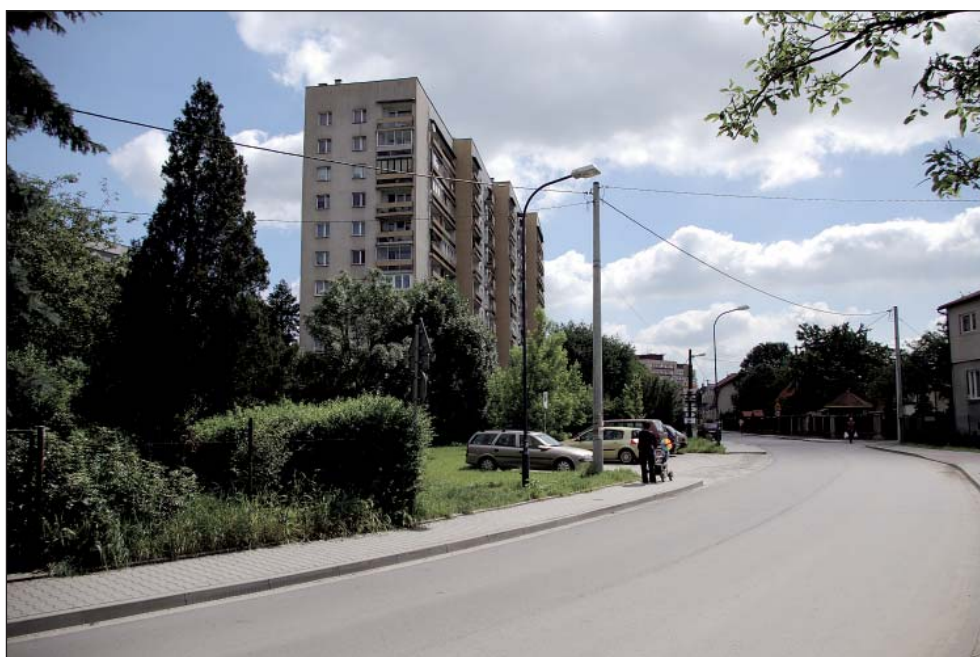
Ul. Śliczna 12A, chodnik, droga i parking po remoncie
