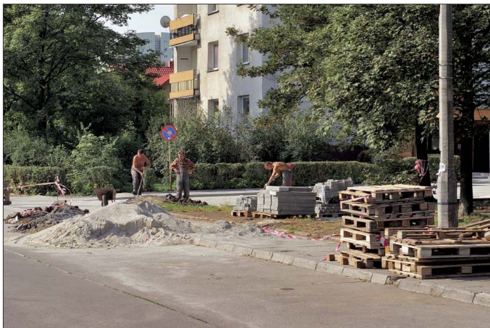
Ul. Śliczna 12A, budowa drogi i parkingu – rok 2008
